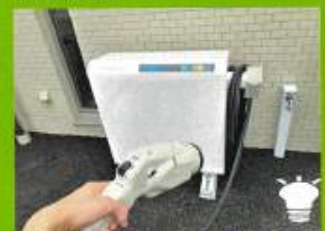
▲非常災害時に必要な電力を車中（PHV車）より供給可能な設備を完備しています。
