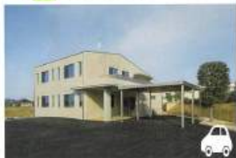
▲玄関はスロータイプになっており、雨天時に利用できるカーポートを準備しています。
