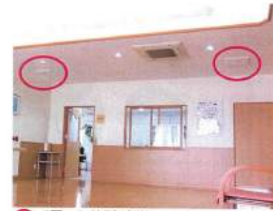
○で囲った箇所が増築した換気設備
