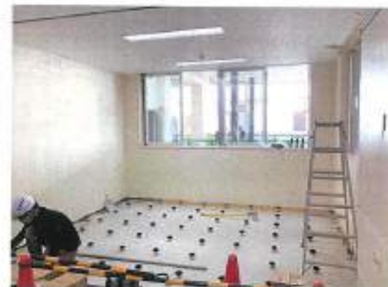
支援員室の拡張工事の様子
